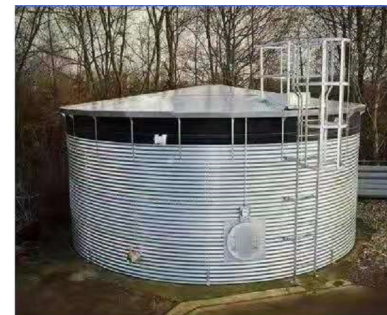
森林消防水池
